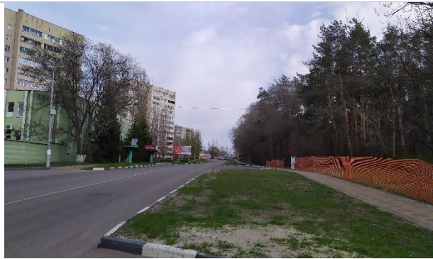
Фотография 7. Окружающая застройка, подъездные пути, фасад здания
