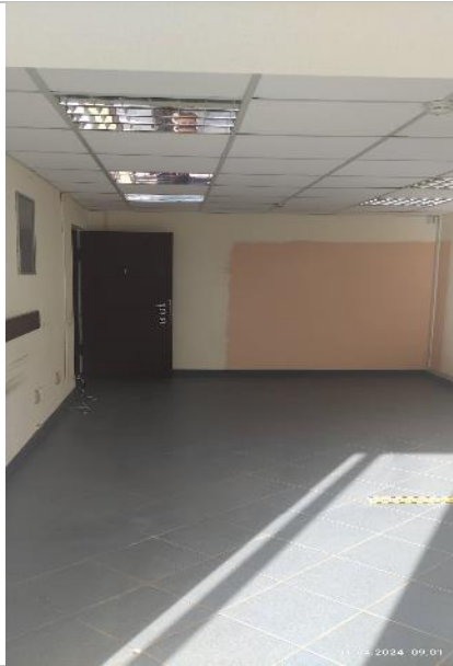
Фотография 8. Фрагменты внутренних помещений объекта оценки
