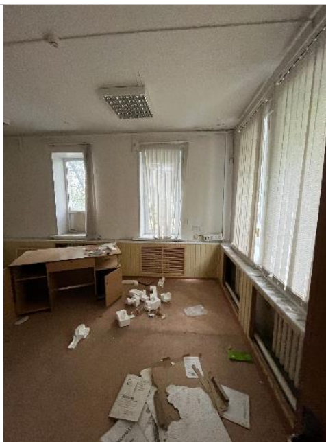
Фотография 58. Внутренние помещения здания
