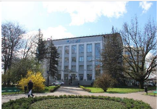
Фотография 1. Внешнее состояние объекта.
