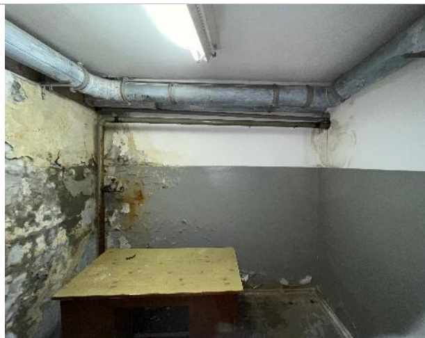
Фотография 63. Внутренние помещения здания
