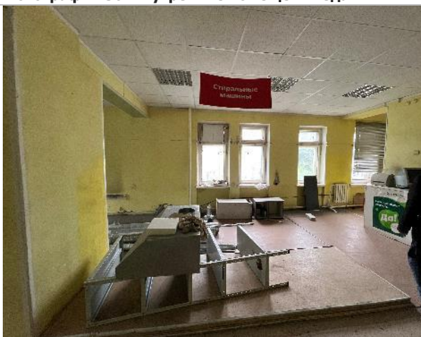
Фотография 38. Внутренние помещения здания
