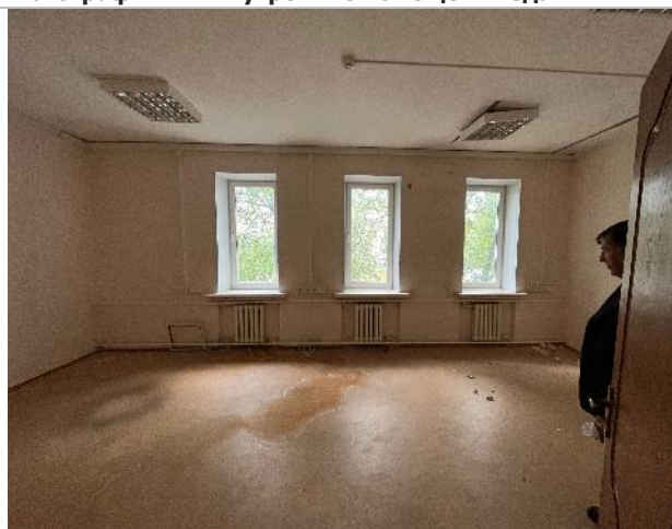
Фотография 49. Внутренние помещения здания
