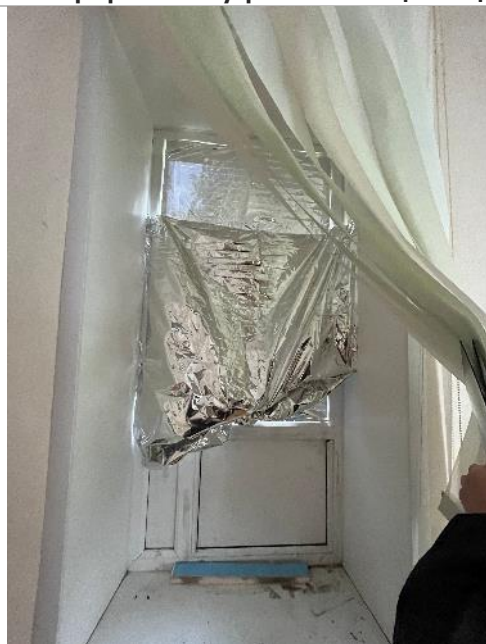
Фотография 47. Внутренние помещения здания
