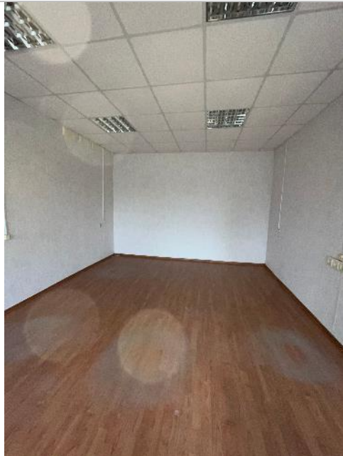
Фотография 53. Внутренние помещения здания
