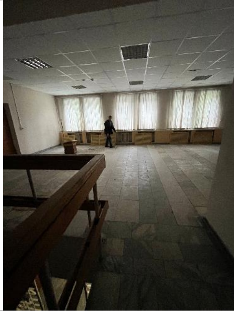
Фотография 51. Внутренние помещения здания
