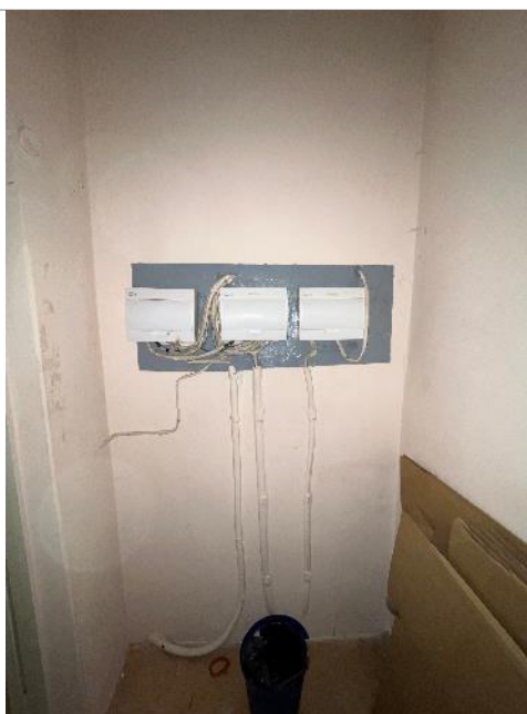
Фотография 60. Внутренние помещения здания
