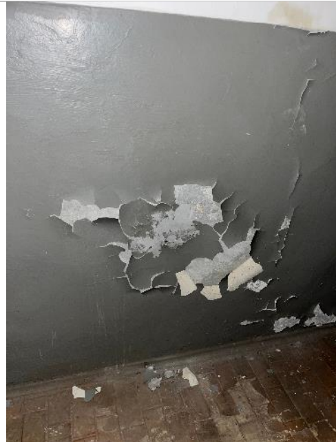
Фотография 16. Внутренние помещения здания
