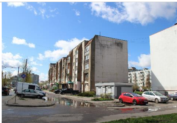
Фотография 1. Фасад здания, в котором расположен объект оценки
