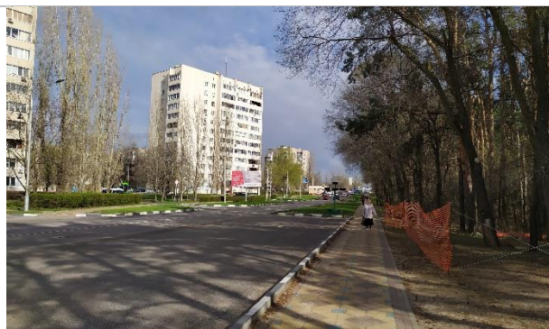
Фотография 14. Окружающая застройка, подъездные пути
