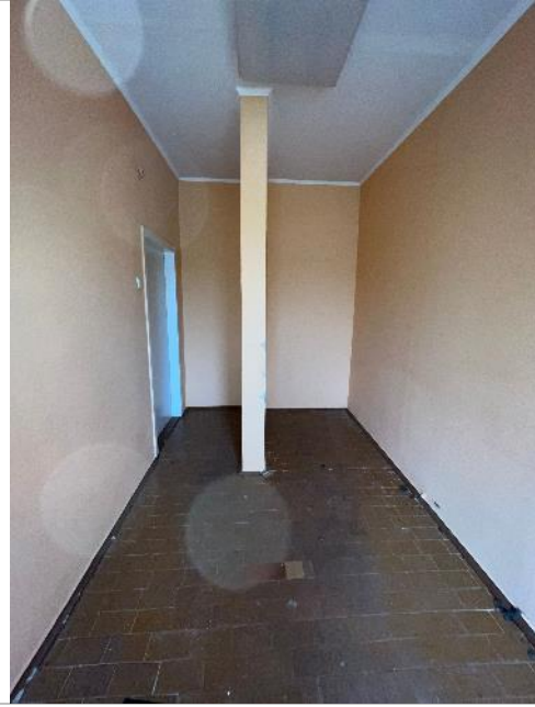
Фотография 52. Внутренние помещения здания
