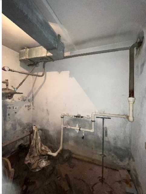
Фотография 21. Внутренние помещения здания
