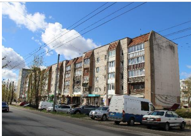
Фотография 9. Фасад здания, в котором расположен объект оценки
