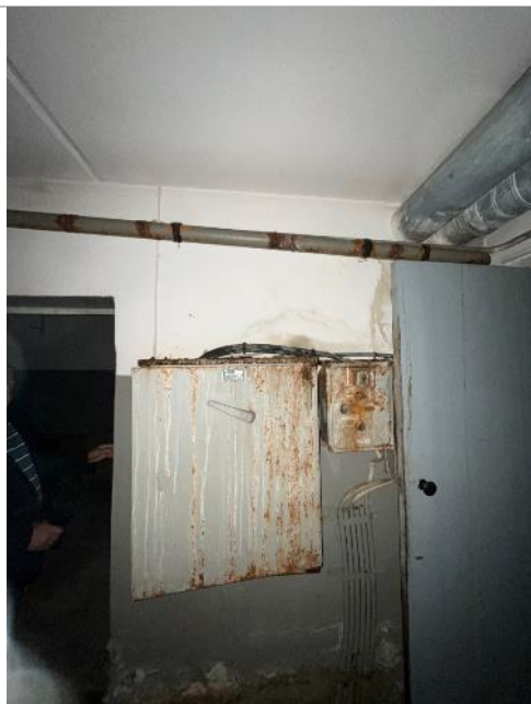
Фотография 19. Внутренние помещения здания
