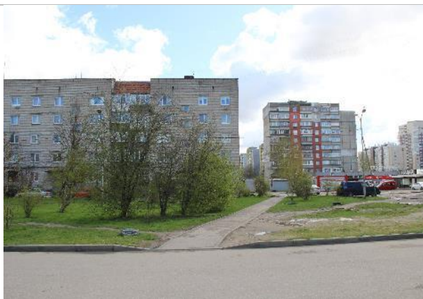
Фотография 6. Подъездные пути, прилегающая территория
