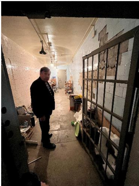
Фотография 31. Внутренние помещения здания
