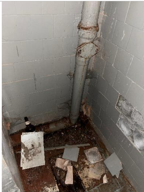
Фотография 23. Внутренние помещения здания
