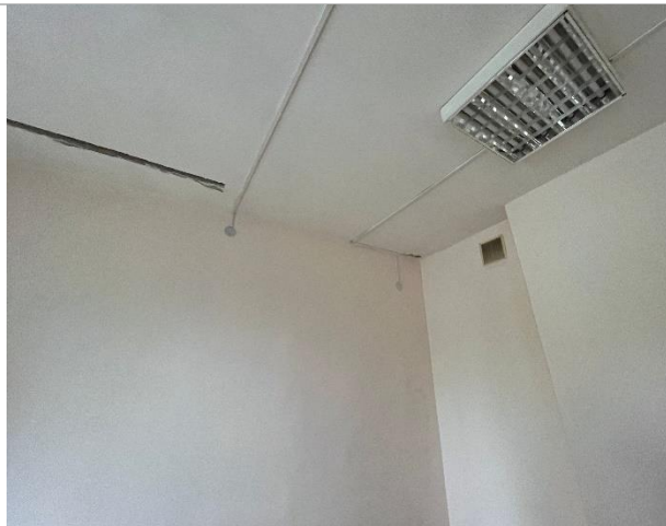
Фотография 55. Внутренние помещения здания
