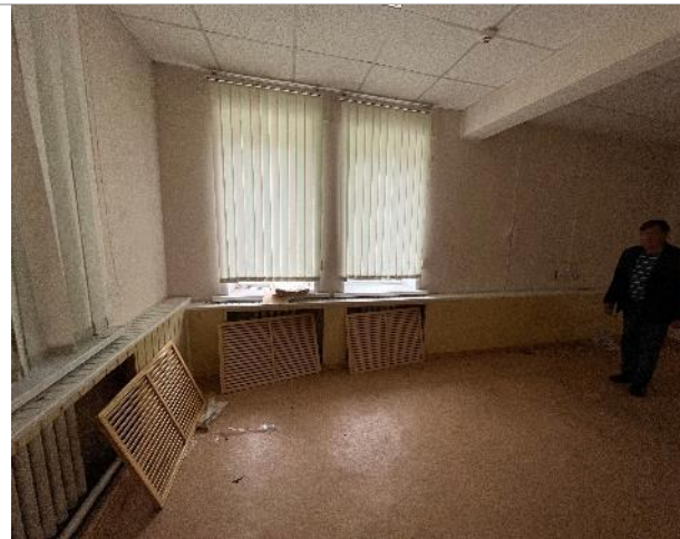
Фотография 41. Внутренние помещения здания
