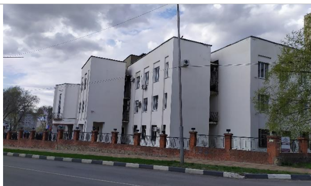
Фотография 11. Окружающая застройка, подъездные пути
