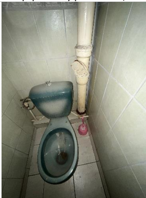
Фотография 48. Внутренние помещения здания
