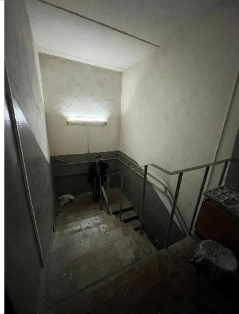
Фотография 14. Внутренние помещения здания
