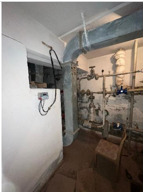
Фотография 20. Внутренние помещения здания
