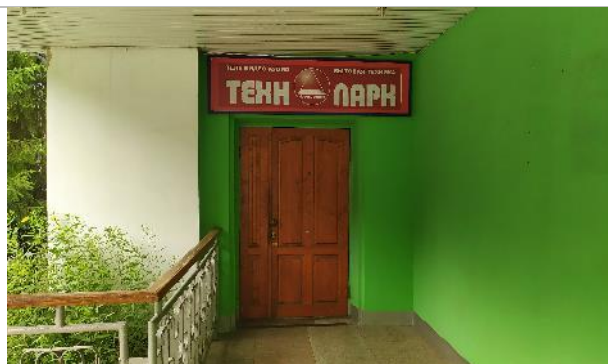
Фотография 18. Входная группа по состоянию на 15.02.2019 г.
