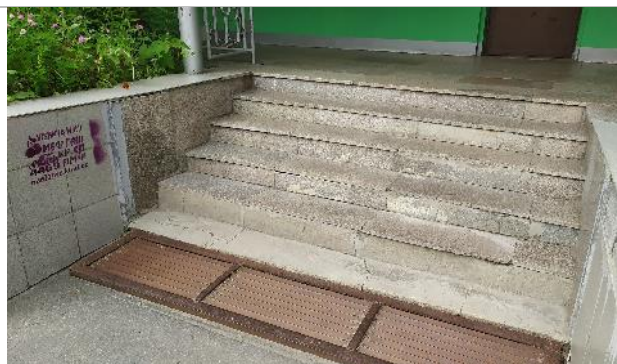
Фотография 17. Входная группа по состоянию на 15.02.2019 г.
