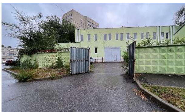
Фотография 8. Гараж, подъездные пути
