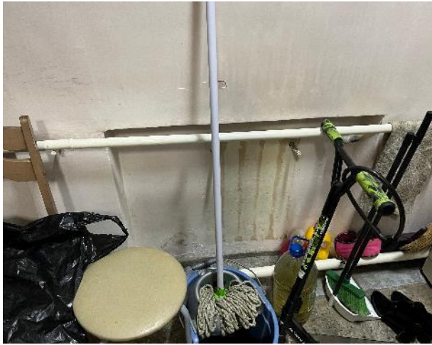
Фотография 29. Внутренние помещения здания
