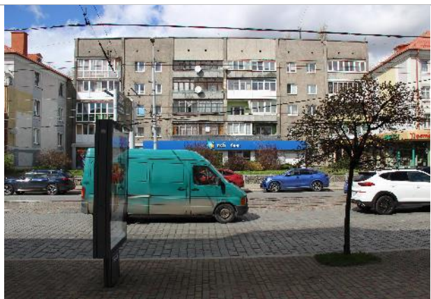
Фотография 19. Подъездные пути
