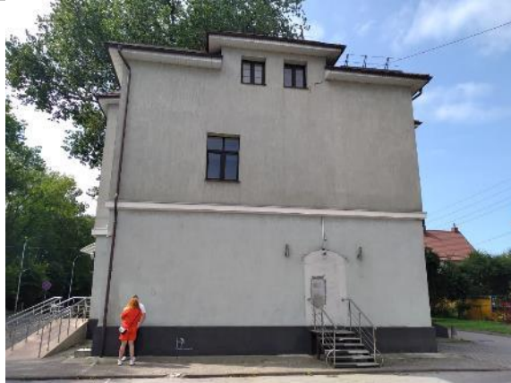
Фотография 3. Внешнее состояние объекта.
