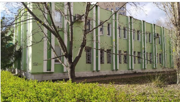
Фотография 3.18. Фасад административного здания
