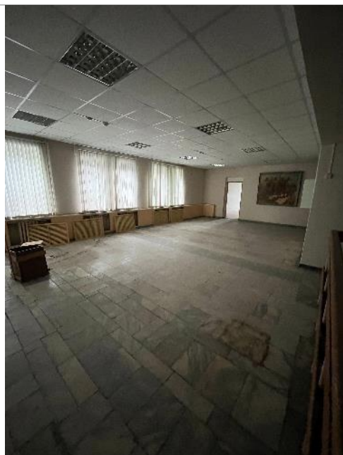
Фотография 45. Внутренние помещения здания
