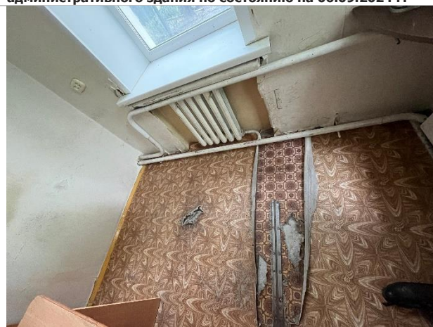
Фотография 3.23. Внутренние помещения административного здания по состоянию на 06.09.2024 г.
