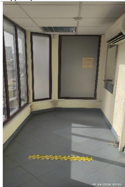
Фотография 6. Фрагменты внутренних помещений объекта оценки
