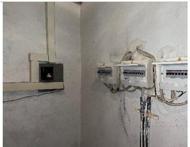
Фотография 64. Внутренние помещения здания
