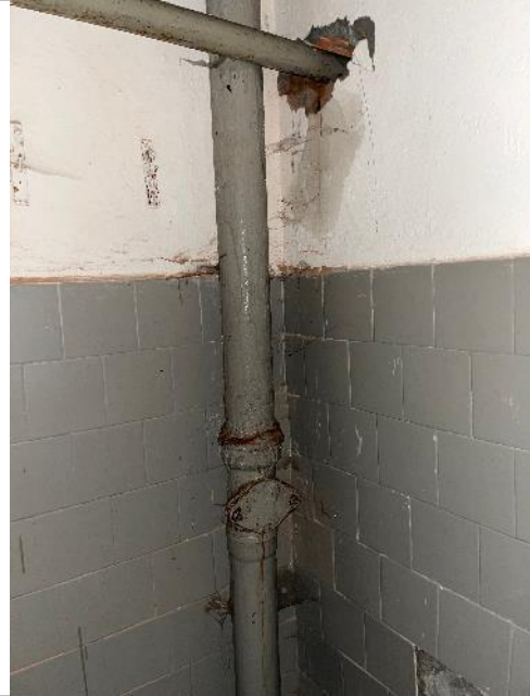
Фотография 22. Внутренние помещения здания
