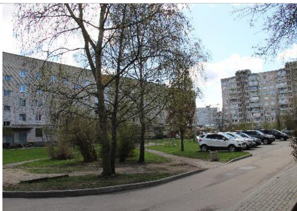
Фотография 4. Подъездные пути, прилегающая территория
