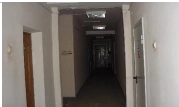
Фотография 16. Внутренние помещения по состоянию на 15.02.2019 г.
