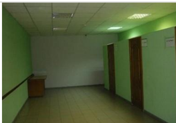
Фотография 19. Внутренние помещения по состоянию на 15.02.2019 г.
