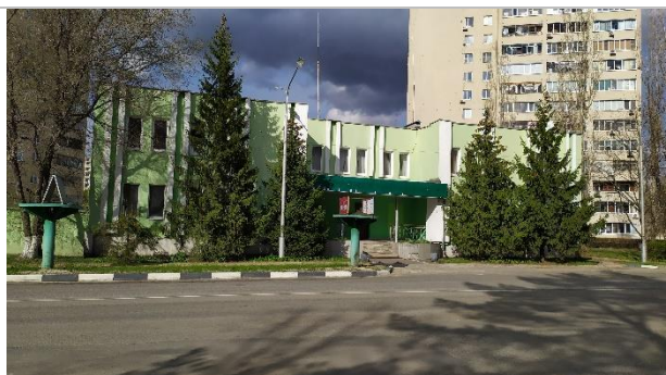
Фотография 3.17. Фасад административного здания
