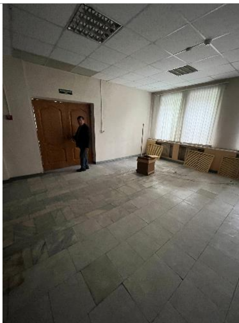
Фотография 46. Внутренние помещения здания
