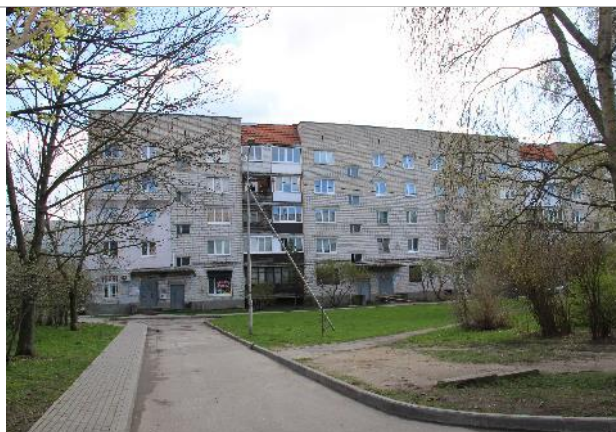
Фотография 3. Подъездные пути, прилегающая территория
