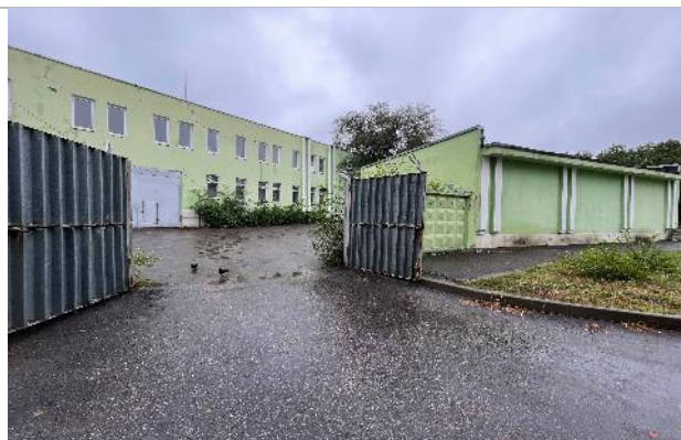
Фотография 7. Гараж, подъездные пути
