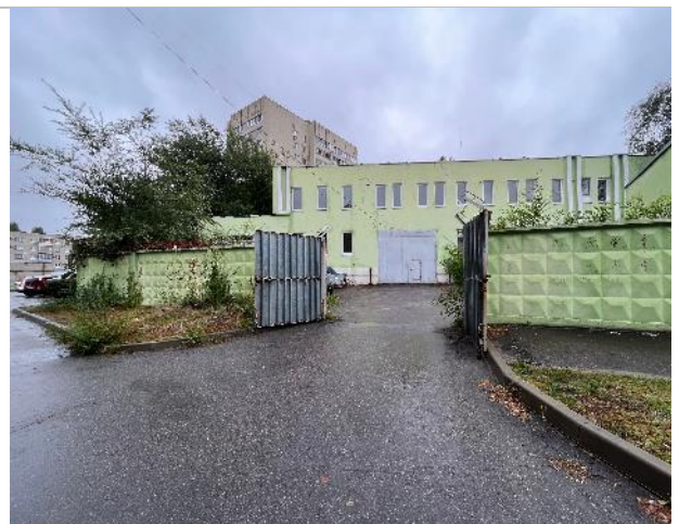
Фотография 6. Гараж, подъездные пути
