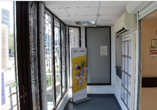
Фотография 11. Фрагменты внутренних помещений объекта оценки
