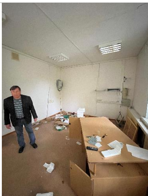
Фотография 59. Внутренние помещения здания
