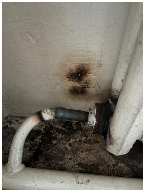
Фотография 57. Внутренние помещения здания
