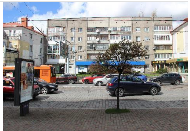
Фотография 18. Подъездные пути
