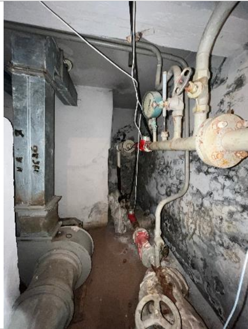
Фотография 61. Внутренние помещения здания
