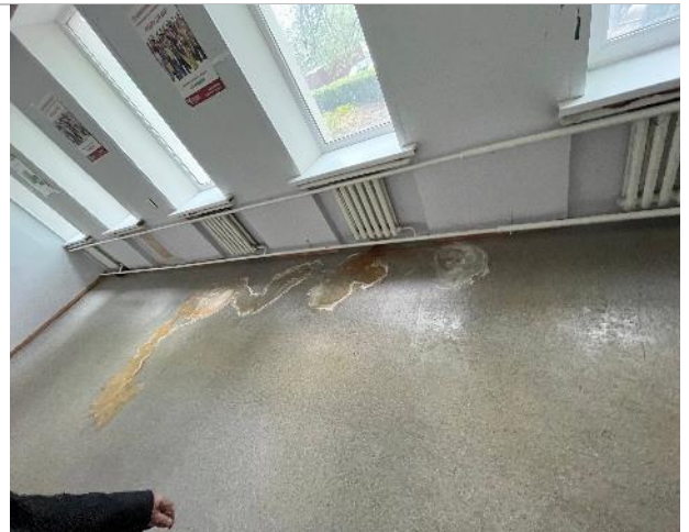
Фотография 42. Внутренние помещения здания
