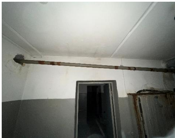
Фотография 17. Внутренние помещения здания
