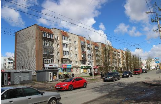
Фотография 3.9. Внешнее состояние объекта
