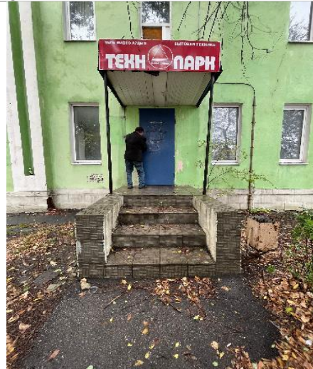
Фотография 2. Фасад здания
