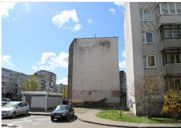
Фотография 2. Подъездные пути, прилегающая территория
