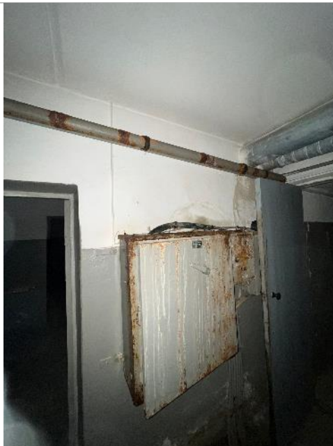
Фотография 18. Внутренние помещения здания
