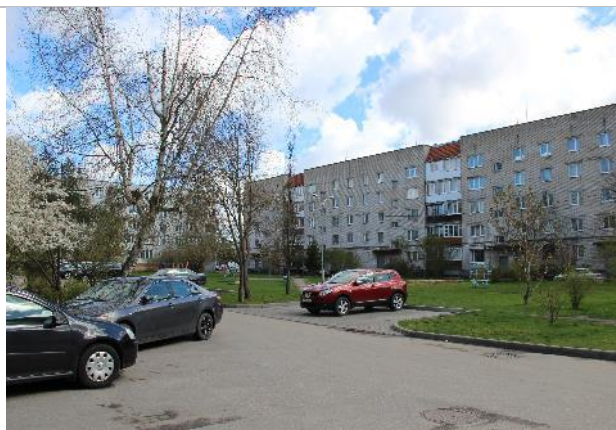
Фотография 5. Подъездные пути, прилегающая территория
