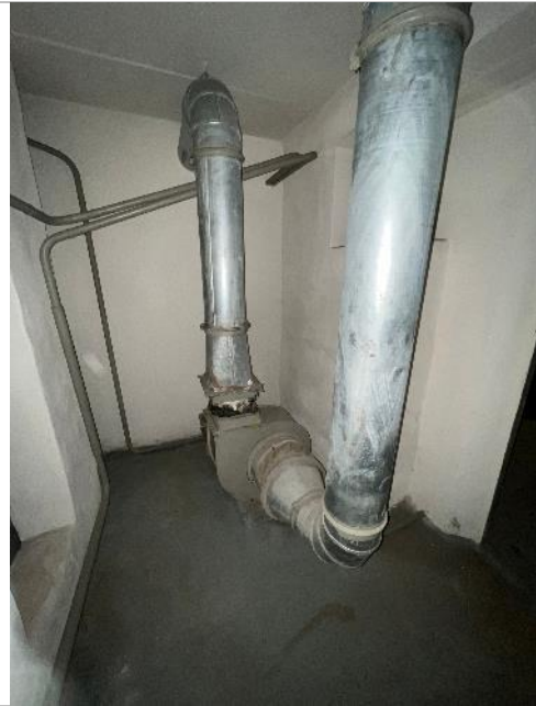
Фотография 62. Внутренние помещения здания
