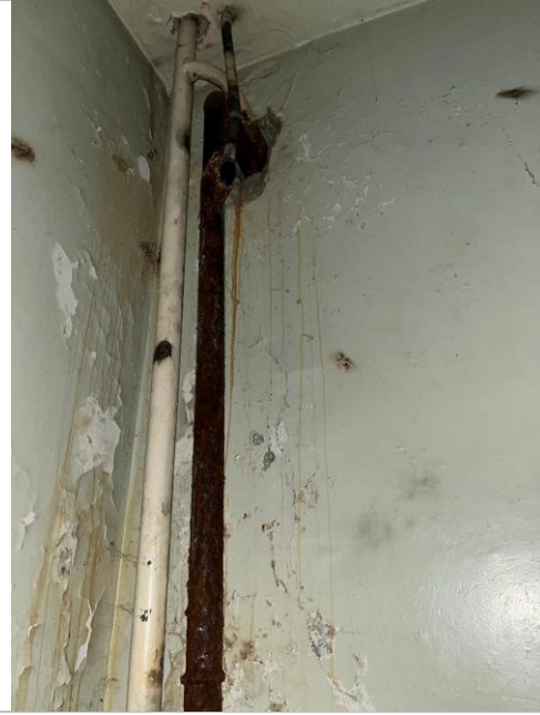
Фотография 39. Внутренние помещения здания
